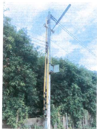
จุดที่ ๕ ซอยซากข้าวเสี้ยน หมู่ที่ ๔ บ้านหัวทุ่ง
